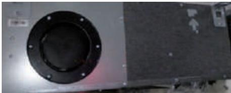
Sul lato dell'unità è presente di serie un raccordo circolare a flangia, diametro 120 mm, per collegare un tubo flessibile per l'immissione d'aria primaria. Normalmente questa flangia è chiusa e fissata al contrario, se non utilizzata.
